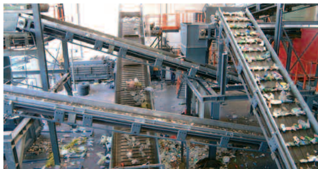
Impianto di selezione plastica.
