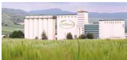
Lo stabilimento di produzione di Flumeri (Av)
