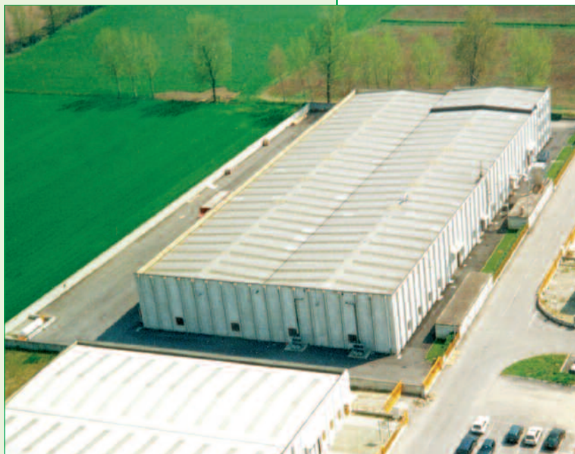
Una veduta aerea dello stabilimento Madi Ventura di Chieve (Cr).
