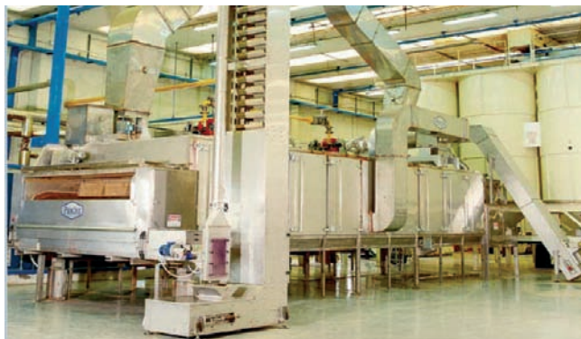
Uno scorcio dei reparti produttivi dello stabilimento di Chieve (Cr).
